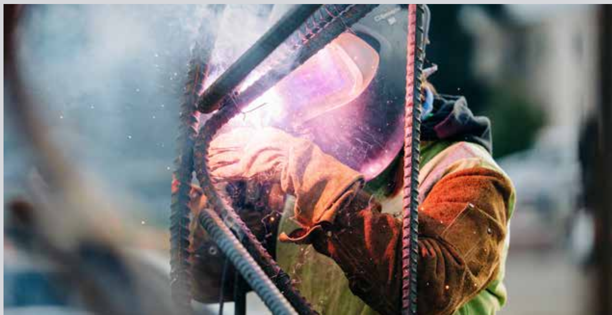
Welder at the Kent Des Moines site
