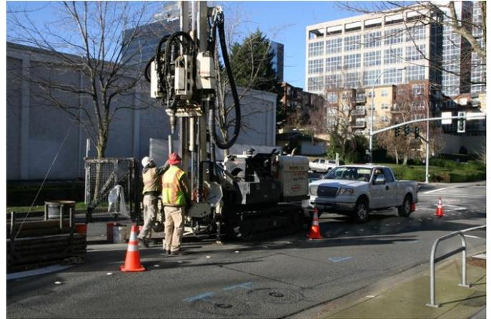
*Ejemplo de equipo de perforación geotécnica*
